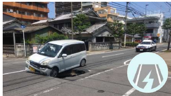
道路等の公共設備破損情報
